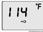
Fig. 36 Estado de bloqueo
